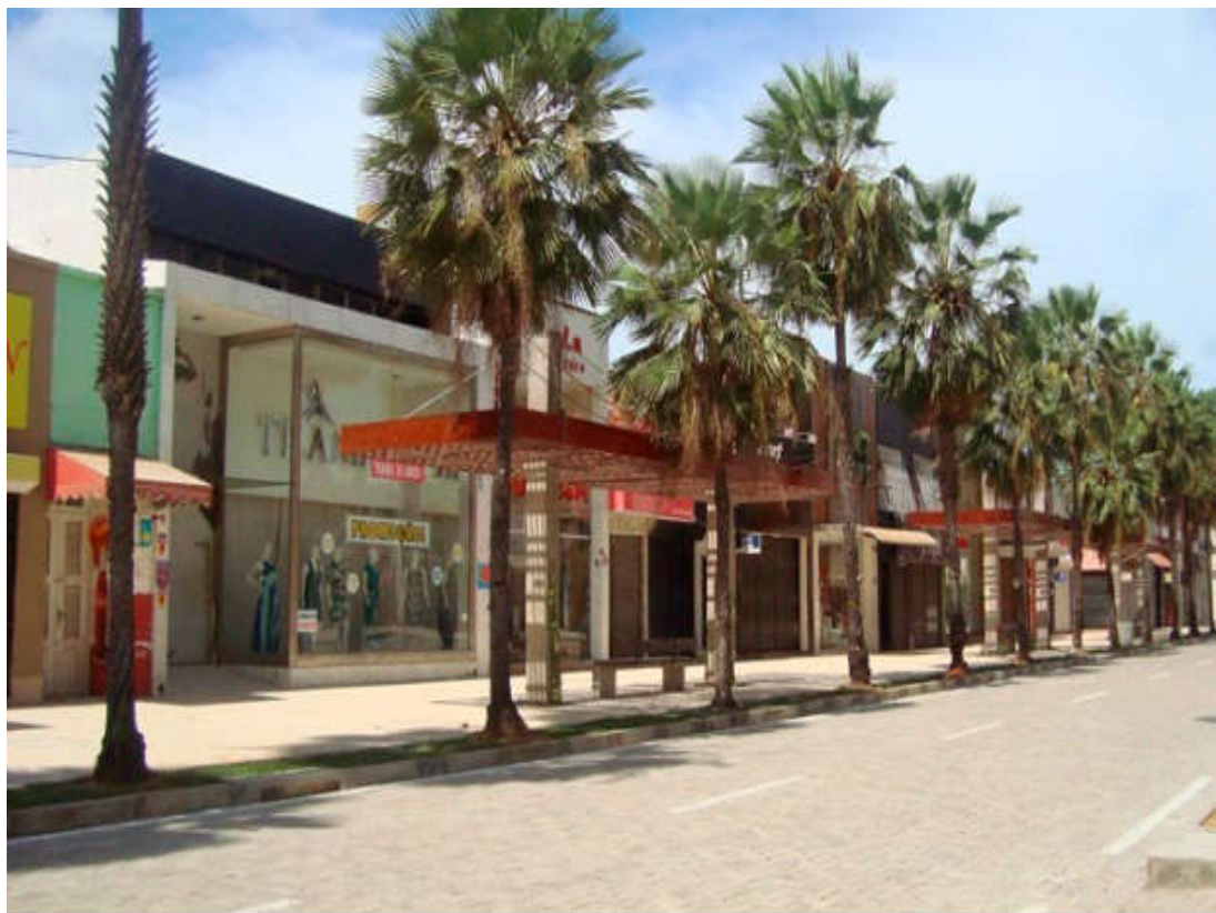
Pavimentação da Rua Monsenhor Tabosa, Fortaleza - Ceará
